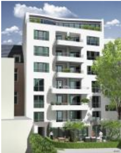
In der Neusser Str. in Köln Nippes entstehen derzeit 15 Eigentumswohnungen in einem KfW 70 Energieeffizienzhaus.
