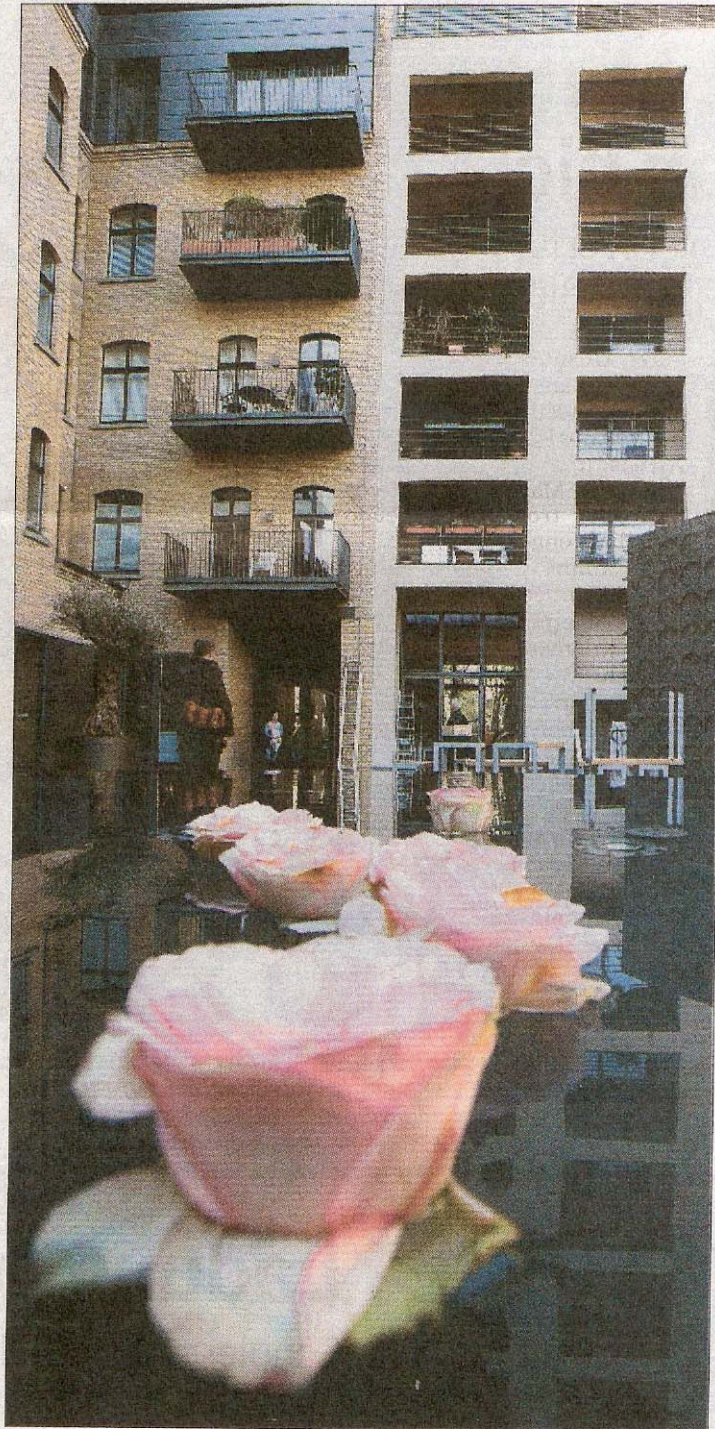
Neues Leben in alten Gemäuern: Die Spichernhöfe am Stadtgarten sind aufwendig ausgebaut worden – und teuer. (Foto: Ohlig)
