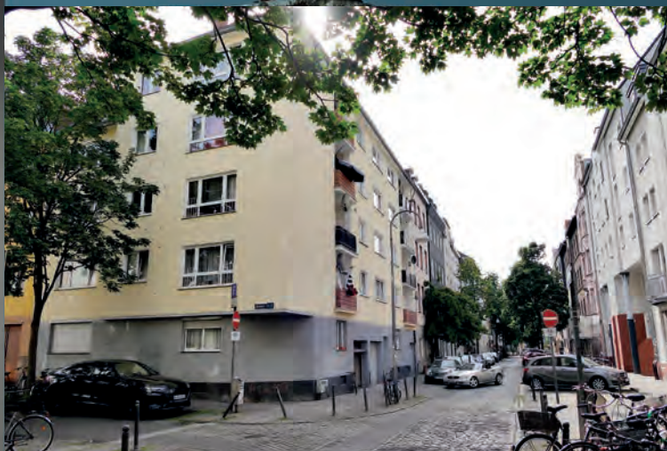
ELSABSTRASSE ECKE BRUNOSTRASSE VOR NEU GEDÄMMTER FASSADE, JULI 2023
