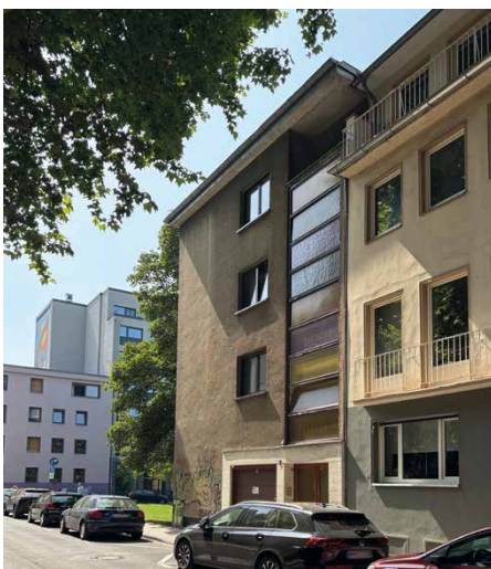
Am Römerturm 7 im August 2025 vor neuer Fassadengestaltung
