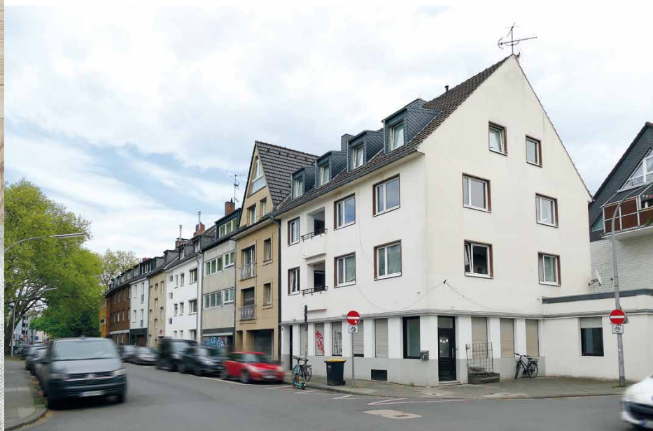
Thieboldsgasse 82 Ecke Alexianerstraße im Juni 2025 vor Neuausbau der Wohnungen 10 und 11 und neuer Fassadengestaltung
