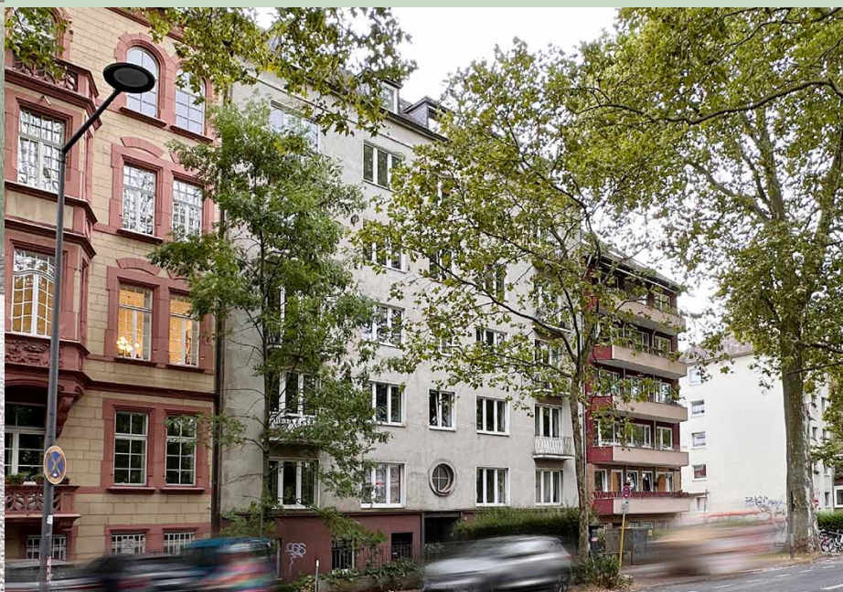
Vorgebirgstraße 7. Juli 2026 vor neuer Fassadengestaltung
