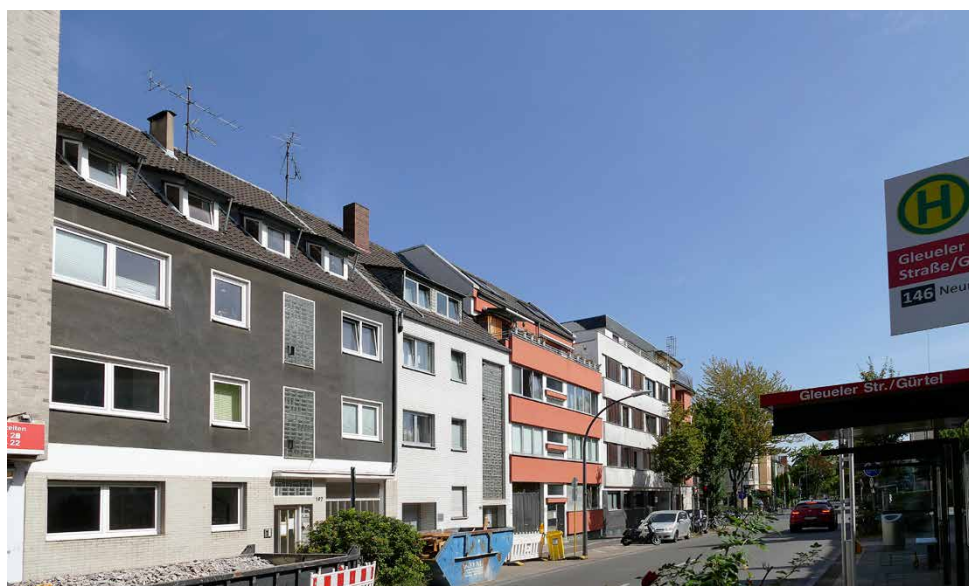
Gleueler Straße mit Haus Nr. 197 im August 2026 vor Aufstockung, Modernisierung und Neuausbau
