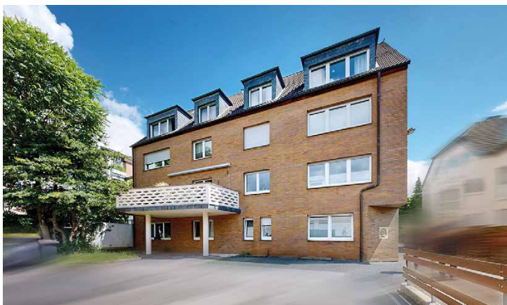
Rückansicht vor neuer Balkonanlage im 2. Obergeschoss.
