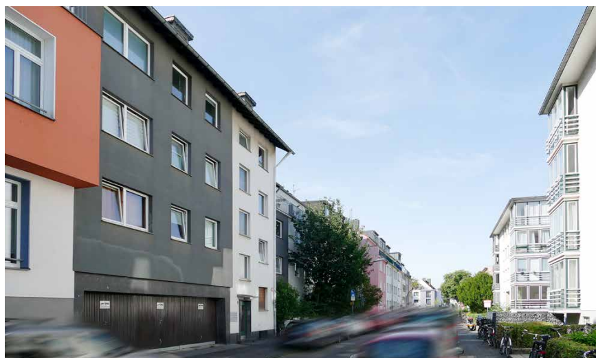
Laudahnstraße 11 im August 2026 vor Neuanstrich Fassade.
